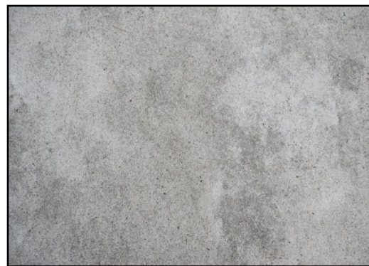
Prefab betonnen gevelementen
