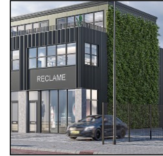
Front zicht Zichtlocatie aan de weg 165 m 2
